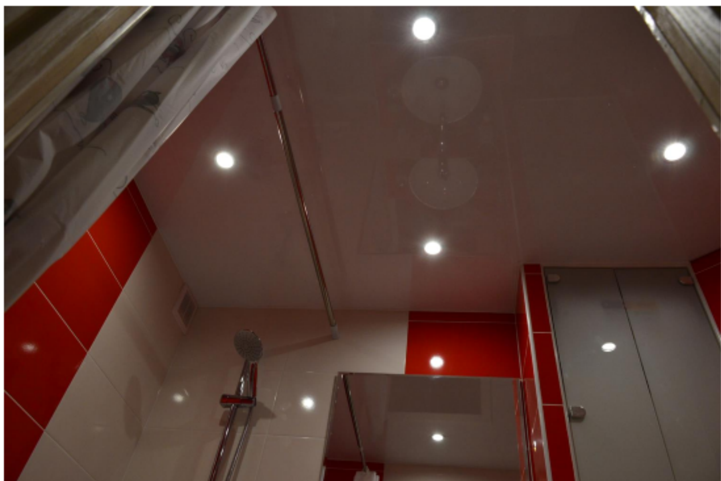
Натяжной потолок – самый простецкий. 4 светодиодные 5Вт лампочки в спотах отлично освещают все пространство.
